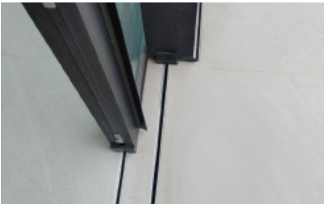
Metal Work / Carpintería Metálica
